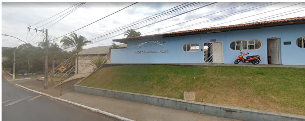
Figura 2: Vista da fachada da Escola José Severiano Filho, demonstrando a proximidade junto ao Centro de Atendimento ao Turista – CAT (à esquerda da imagem, em meio às árvores) Fonte: Google Maps (2022).
