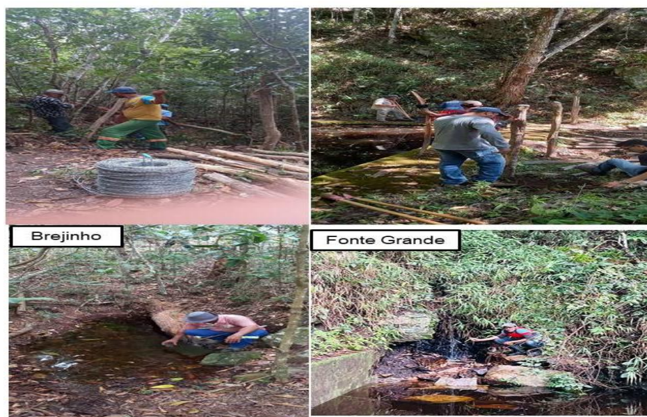
Figura 2: Cercamento das nascentes de Jenipapo.
