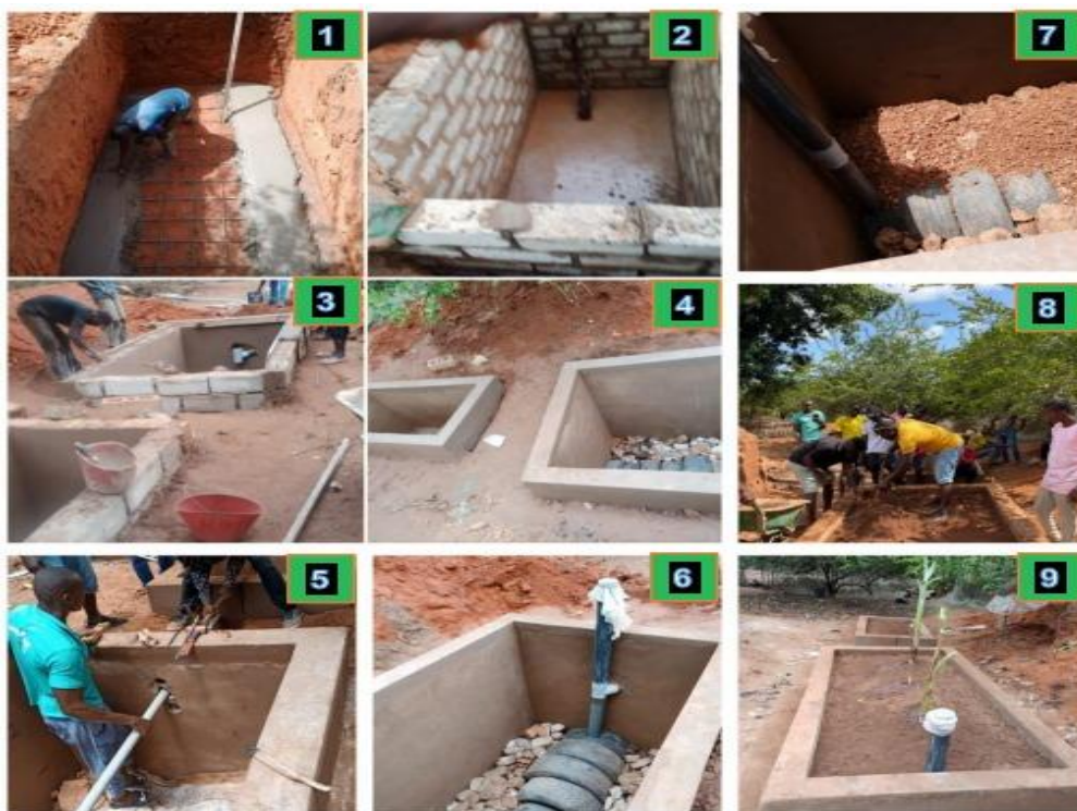
Figura 4: Mosaico fotográfico representando diferentes momentos na fase de construção da fossa ecológica TEWetland, na comunidade de Cool noroeste da Guiné-Bissau, como parte do curso de capacitação para a construção de fossas ecológicas.
