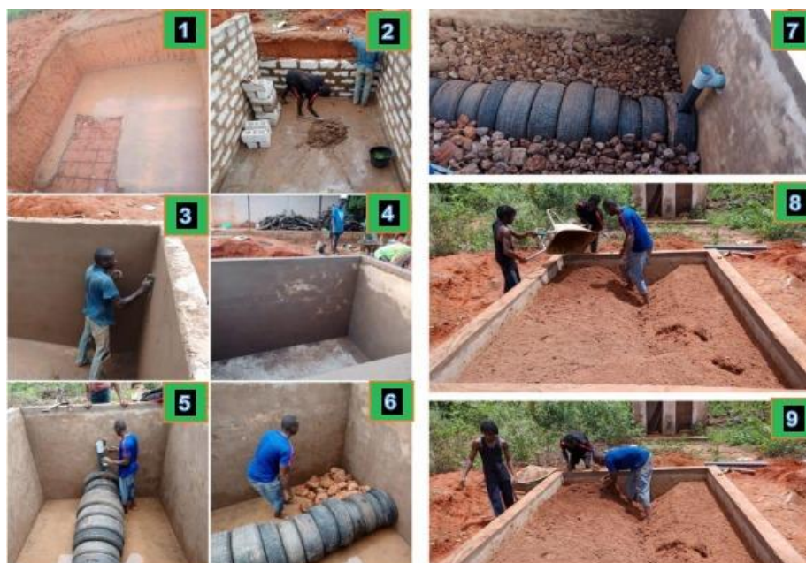
Figura 5 – Mosaico de fotos da construção de TEWetland em Colonato como parte do curso de capacitação para a construção de fossas ecológicas em Guiné-Bissau.
