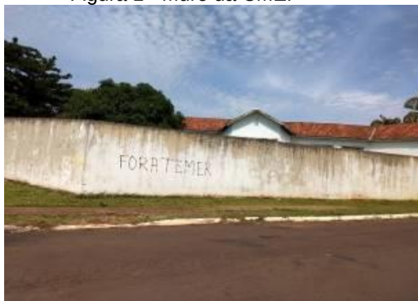
Figura 1 - Muro da CMEI
