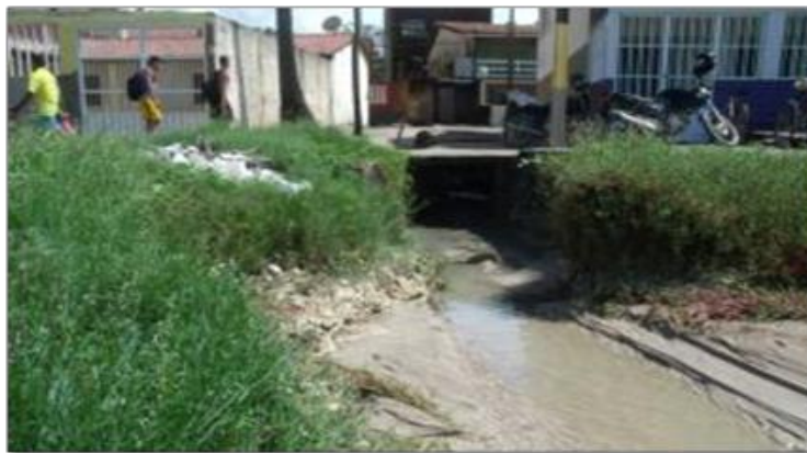
Figura 4: Galeria de águas pluviais transformada pelos moradores do Adélia Lira em esgoto – dejetos deságuam no trecho final da orla de Maragogi. Fonte: Lins (2015).
