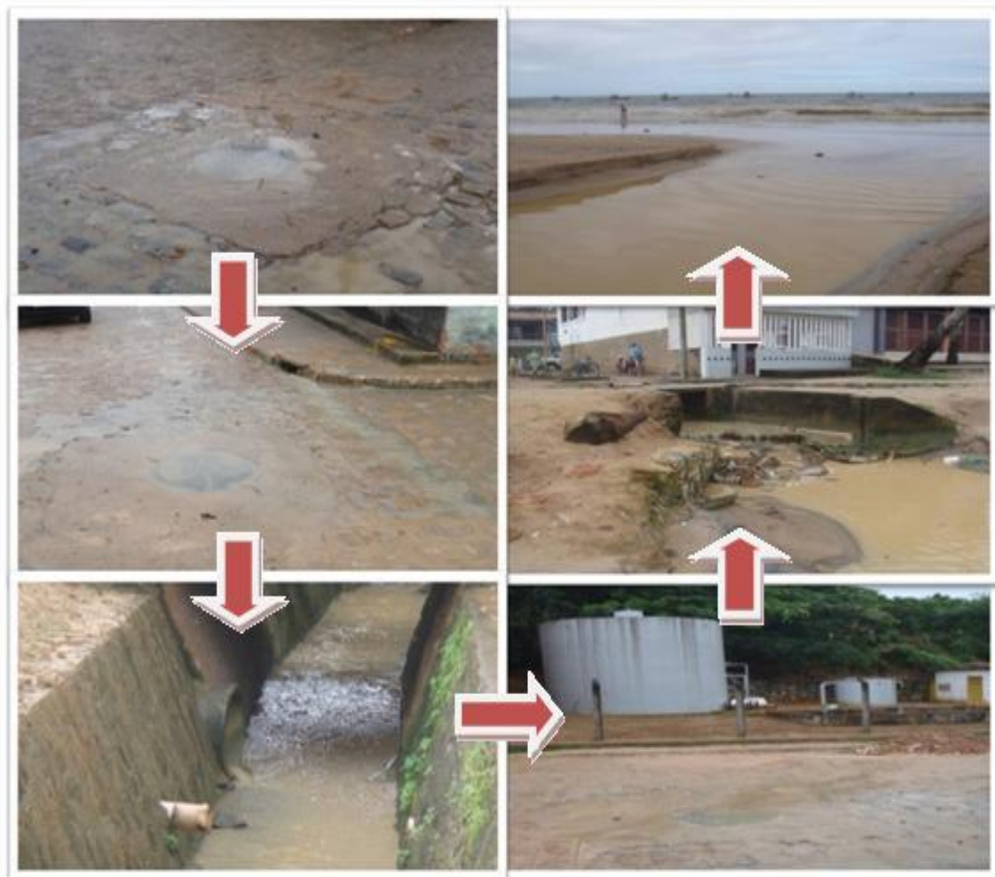
Figura 5: Esgoto correndo a céu aberto no conjunto habitacional Adélia Lira (Grotta) desde o vazamento no poço de visitas, passando pela rede de drenagem urbana até o mar.
