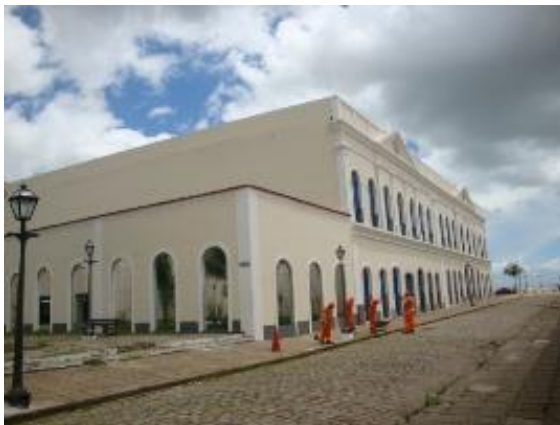
Figura 3: Casa do Maranhão. Figure 3: Maranhão's House. Fonte: autores. Source: authors.
