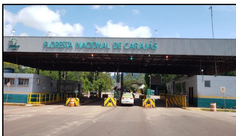
Figura 2: Portaria principal de acesso para a Unidade de Conservação.
