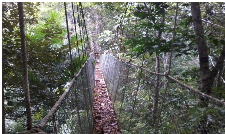
Figura 2: Trecho de passarelas suspensas da trilha do Ecoparque de Una. Figure 2: Stretch of suspended walkways of the Ecoparque de Una trail.
